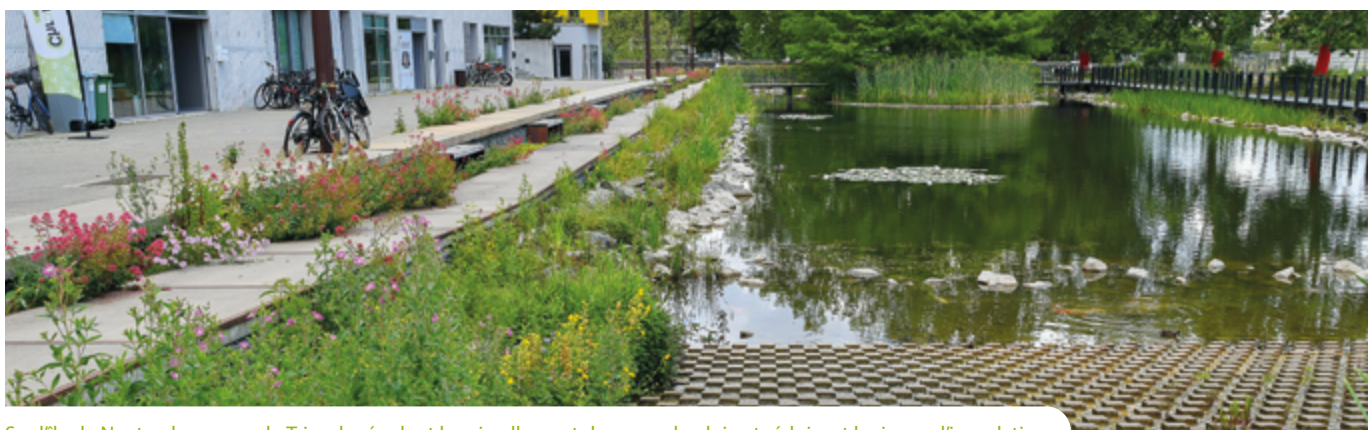
Sur l'île de Nantes, les noues du Tripode régulent le ruissellement des eaux de pluie et réduisent le risque d'inondation.
