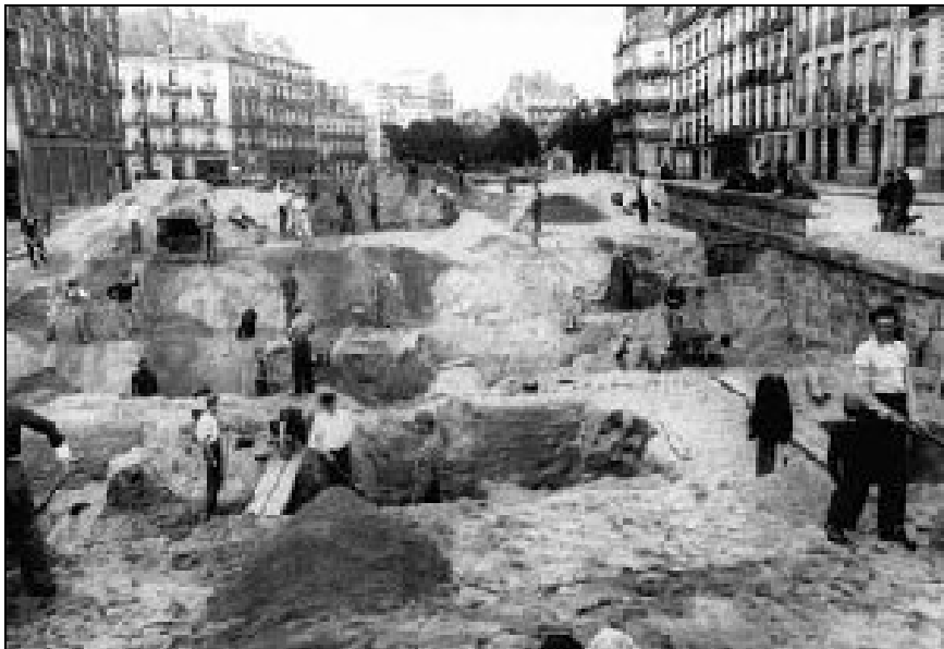
Travaux lors du détournement de l'Erdre en 1935
