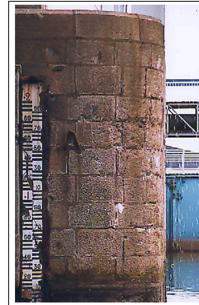
Echelle limnimétrique sur le pont de Sucé/Erdre
