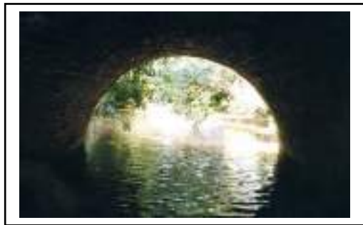
Pont du Verdier
